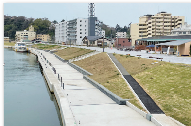
石巻元気いちば前の堤防 背後の商業施設と堤防が同一レベルで接続される
